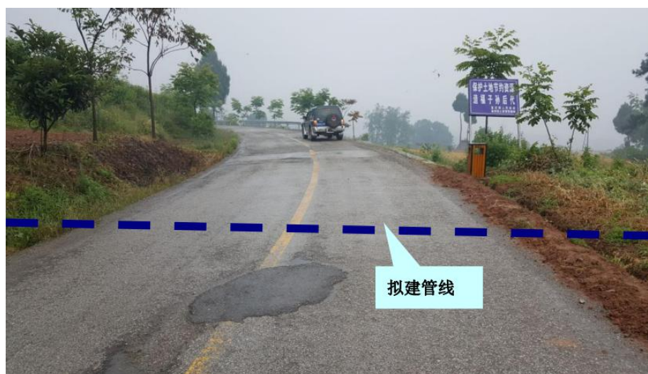
图 3.1-9 管道穿越 Y107 乡道现状照片
