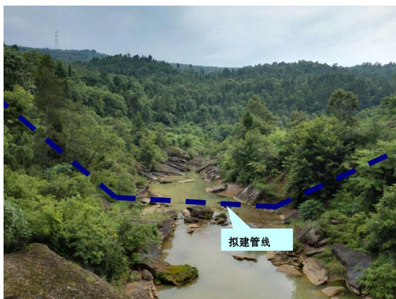
图 2.4-5 管道穿越铁炉沟现状
