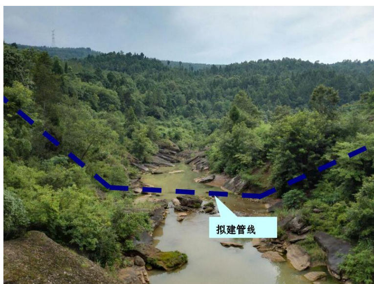
图 3.1-6 围堰导流开挖穿越铁炉沟处现状照片
