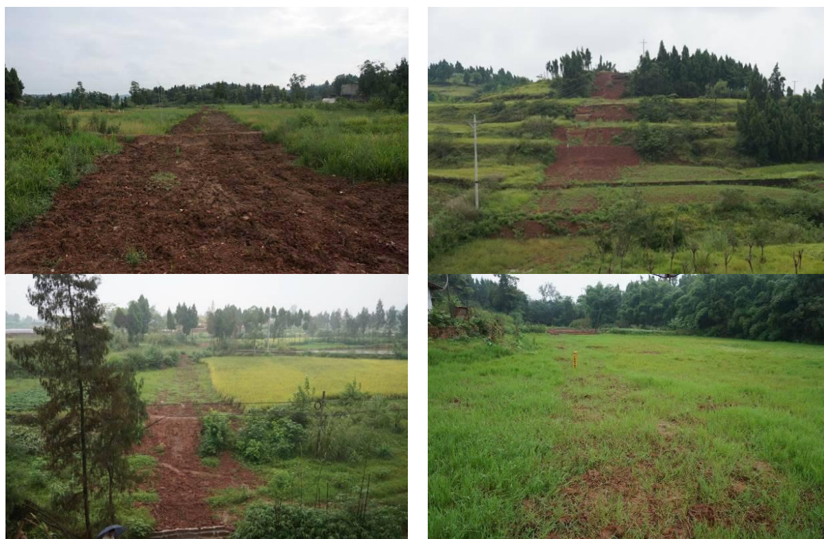
图 7.3-4 区域已有同类工程管道施工恢复情况
