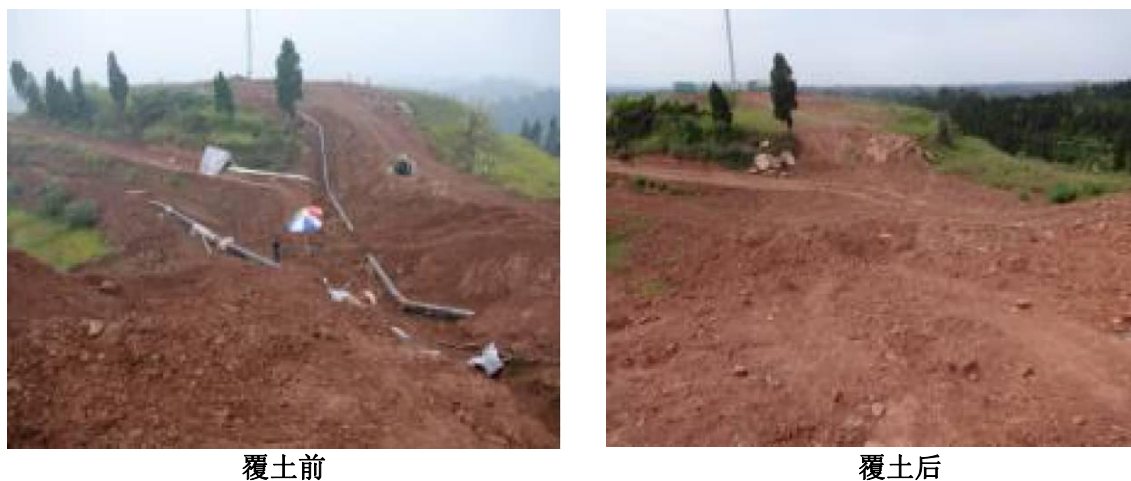
图 7.3-2 区域已有同类工程管沟回填前后对比图
