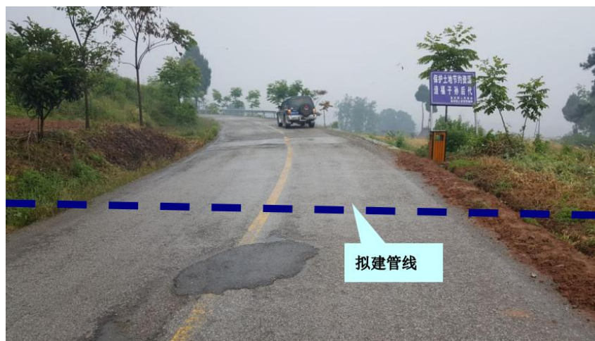
图 2.4-3 管道穿越 Y107 乡道现状
