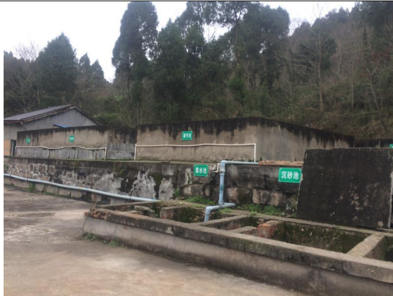
图 5-4 本项目污水处理站现状
