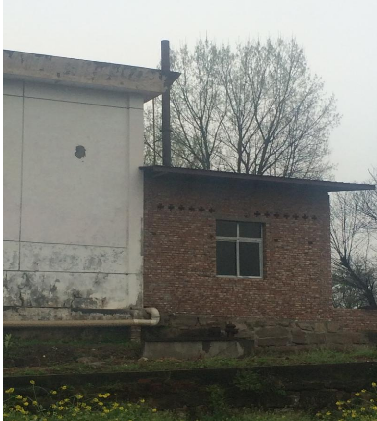
图 5-3 本项目锅炉房及排气筒高度
