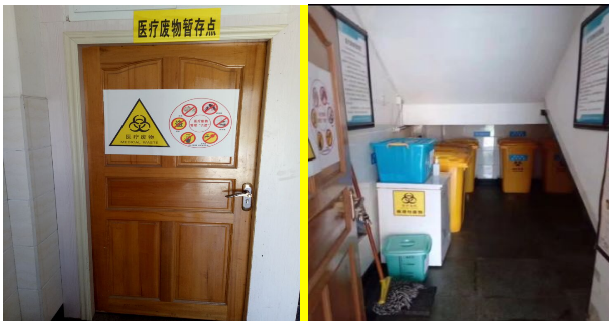
(门诊楼医疗废物暂存间现场照片)
