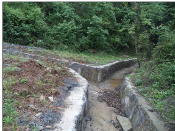
弃土场边界排洪沟
