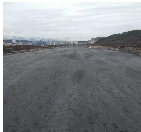
北侧快速通道(在建)
