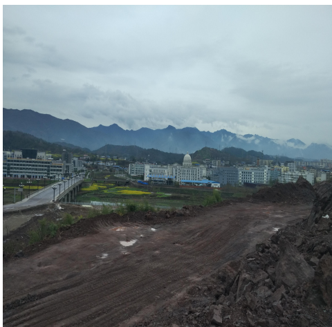
项目建设场地现状
