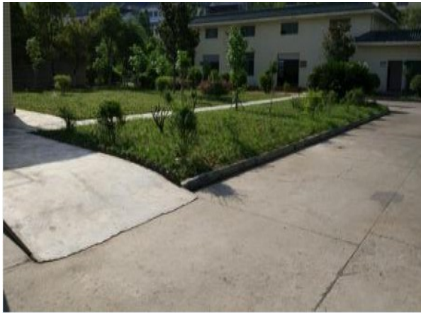
图 1-1 拟新建滤池提升泵站处现状
