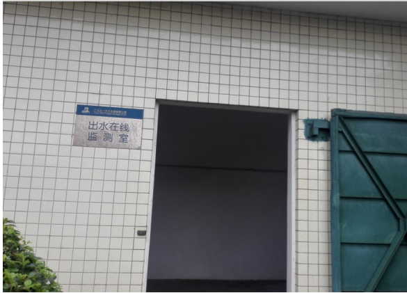
图 1-13 出水在线监测室
