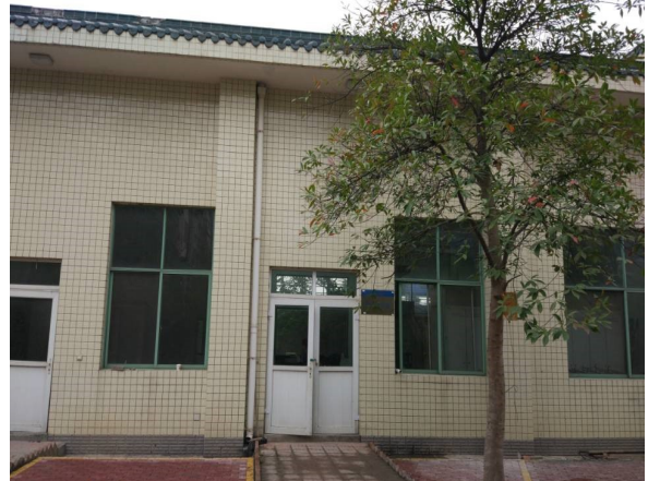
图 1-2 已建变配电间
