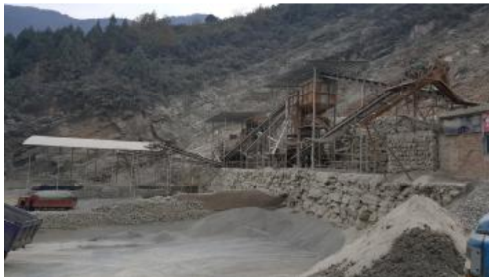
项目现场照片
