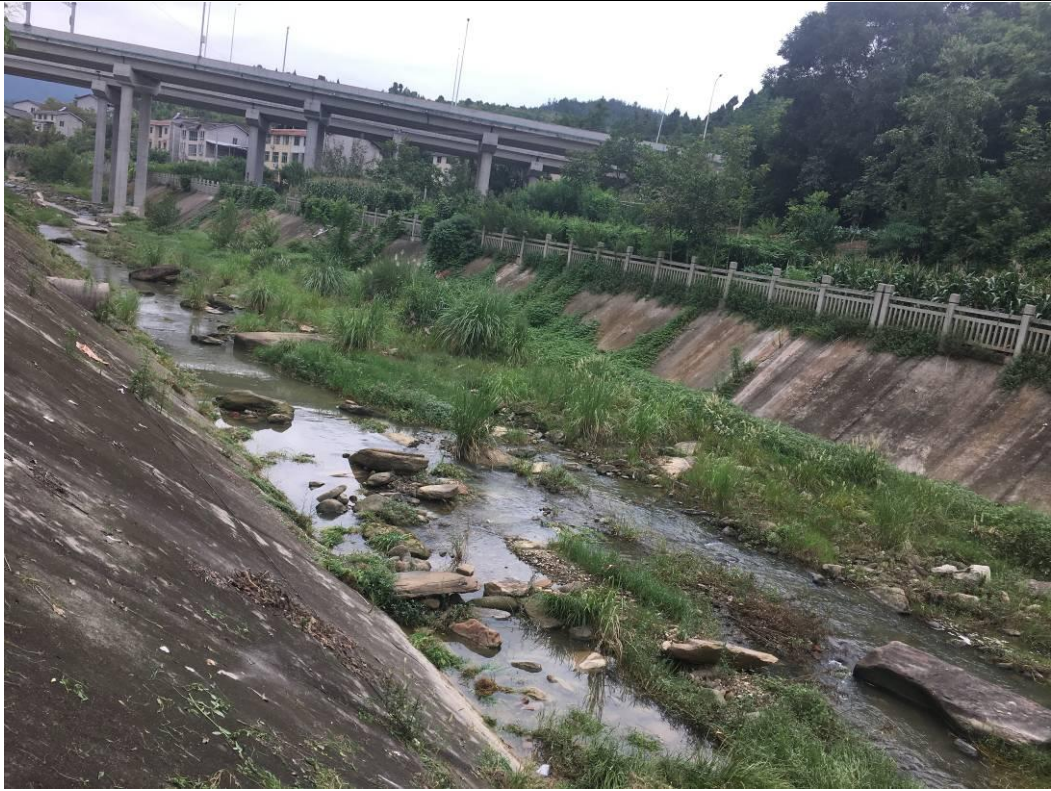
图 3-1 缠龙河现场照片
