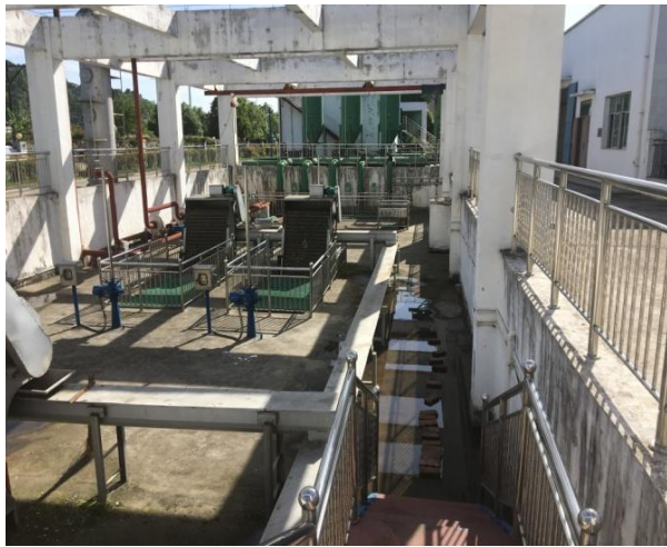
原宝轮镇污水处理厂粗、细格栅现状图（本项目利旧）
