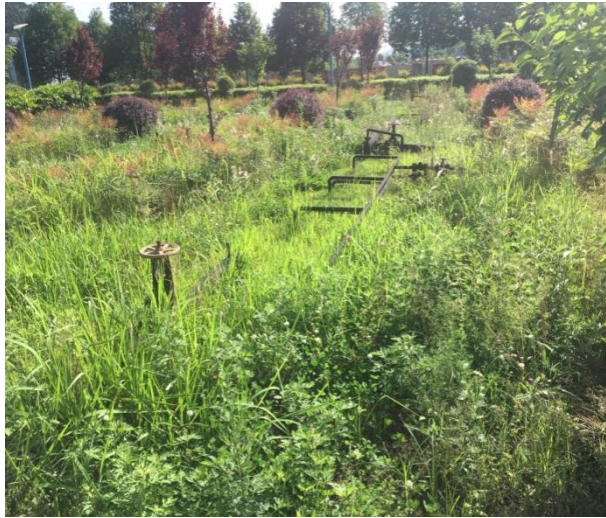
原宝轮镇污水处理厂 LPCA 系统现状图（已废弃）
