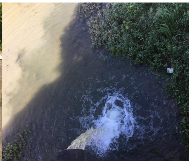
广元市利州区宝轮镇污水处理厂排污口现状图
