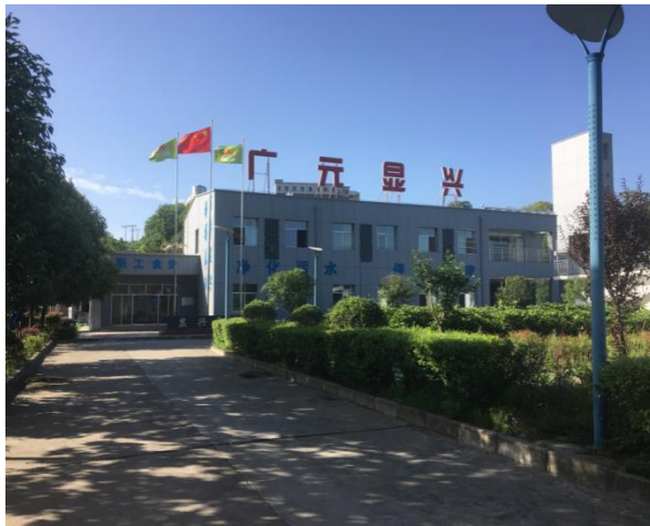
原宝轮镇污水处理厂办公楼（本项目利旧）
