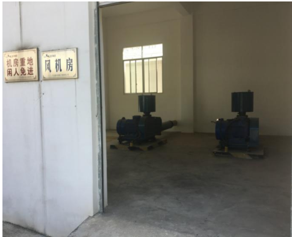
本项目新建鼓风机房现状图
