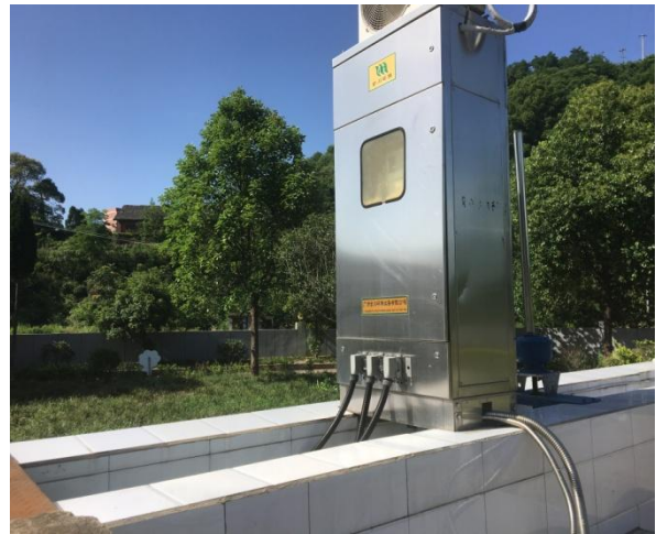
原宝轮镇污水处理厂总排口、消毒系统现状图（本项目利旧）
