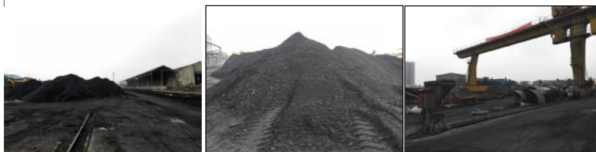
图 1-1 项目现场照片
