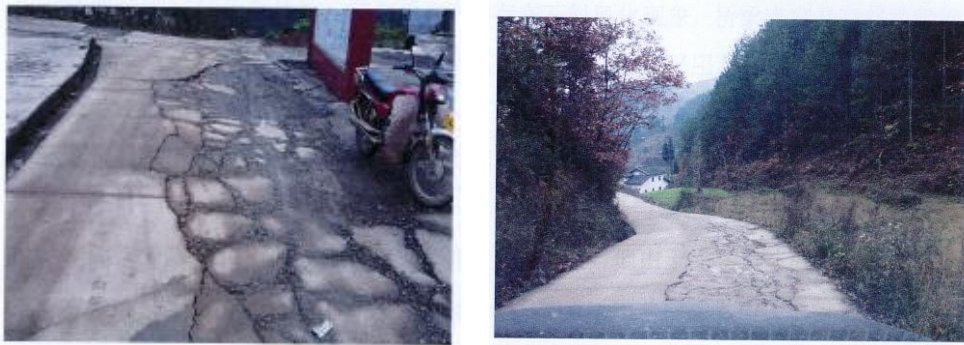
图 1 路面损坏示意图
