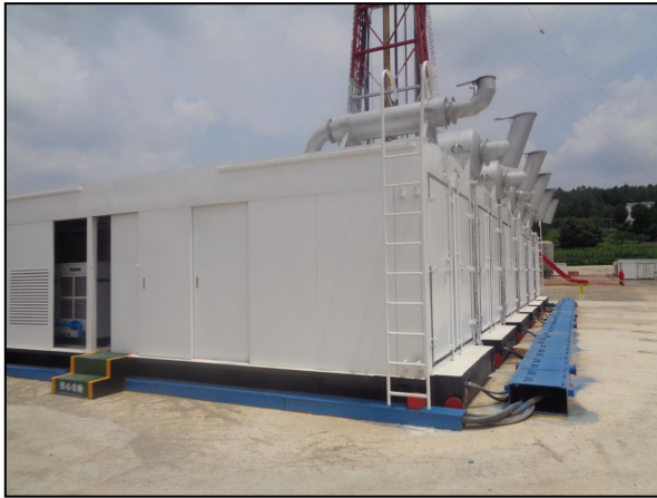
图 1-13 已建发电机房现状
