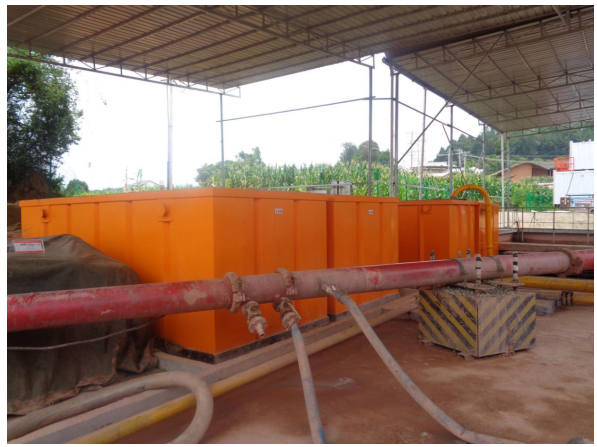
图 1-14 岩屑罐及废水罐区域设置围堰及雨棚
