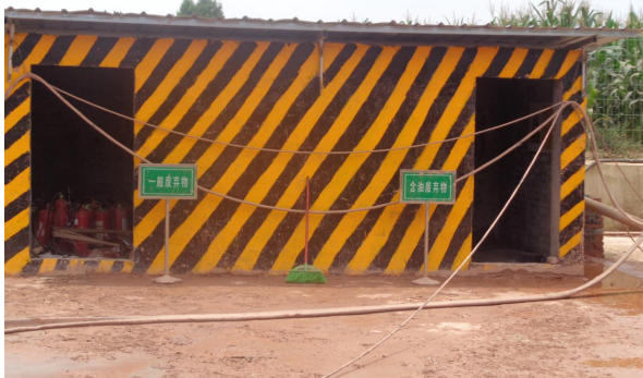
图 1-15 已建危废暂存间现状
