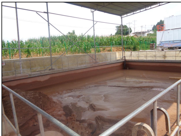
图 1-9 已建转运池现状
