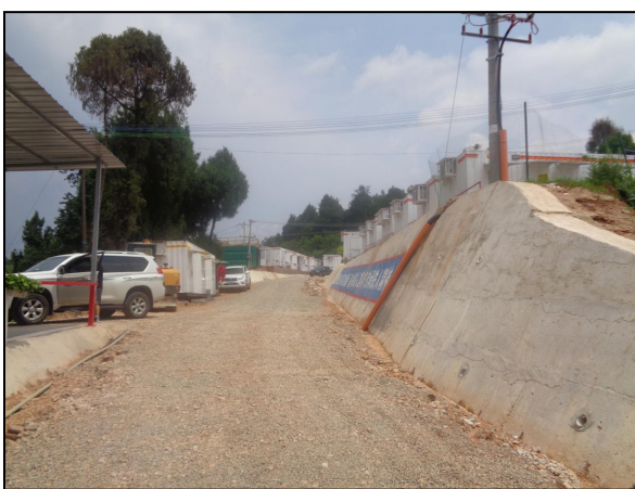
图 1-8 已建临时值班房现状
