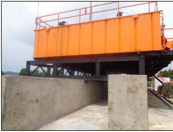
图 1-11 已建泥浆储备罐区现状
