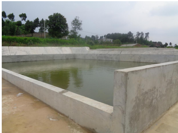
图 1-8 已建转运池现状
