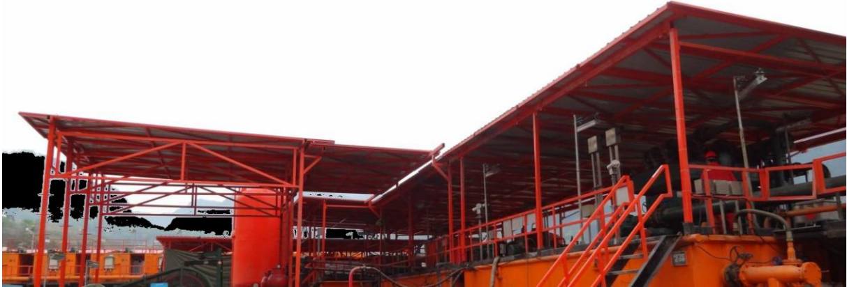
图 5-8 其他钻井工程泥浆循环设施现状图
