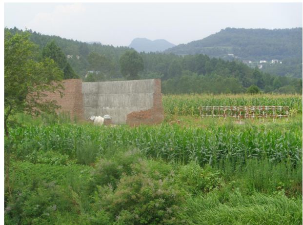
图 1-9 已建放喷池现状
