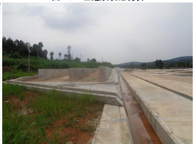
图 1-11 已建储备罐基础现状
