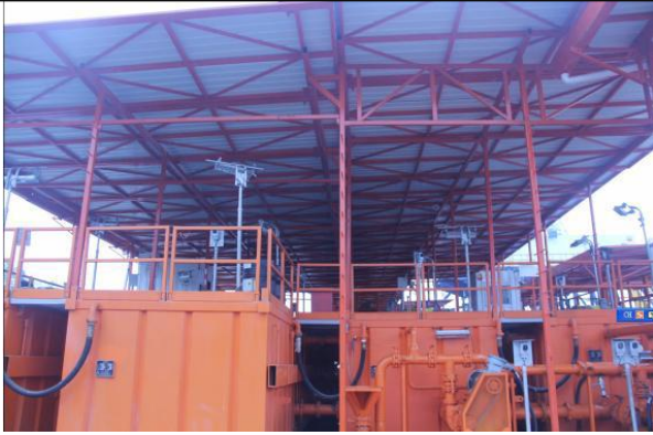
污水处理区雨棚
